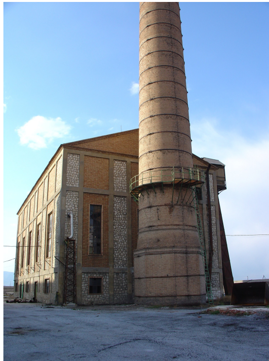
Vista de la gran chimenea de la fábrica azucarera.
